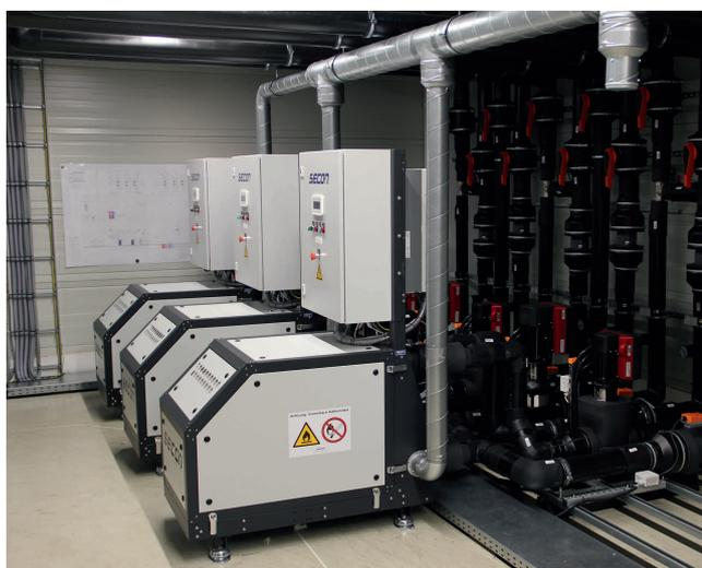
Drei FXP-Kompakt-Chiller von Secon bilden das Herzstück der neuen Kälteanlage – zukunfts-fähig mit Propan betrieben. © Hauff
